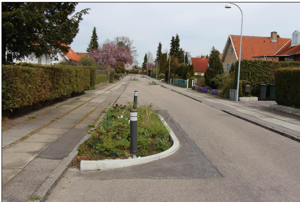
Figur 21. Regnrabatt som multifunktionellt farthinder, renings- och fördröjningsanläggning (Foto: Norconsult).
