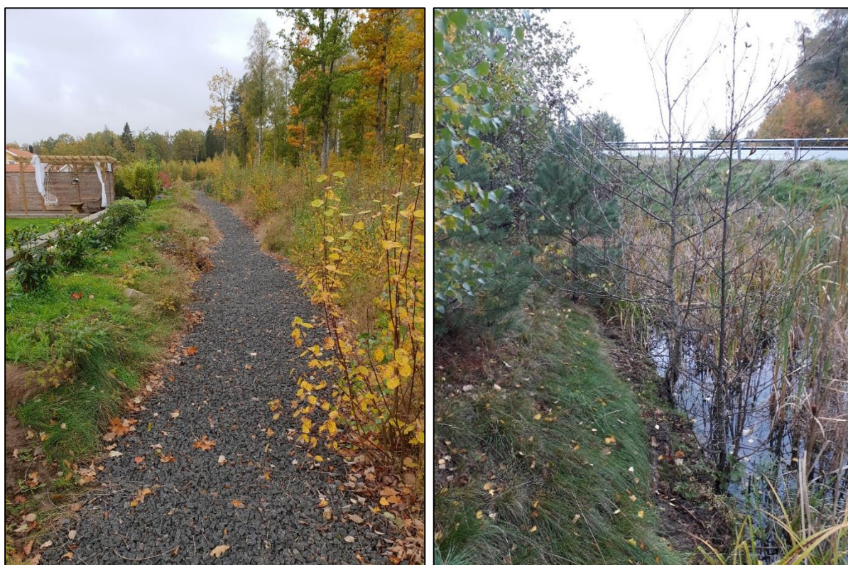
Figur 8. Djupdränering i skärning mellan skogsslänt och bostäder samt dagvattendamm nedströms ledningsnätet (Foto: Norconsult).
