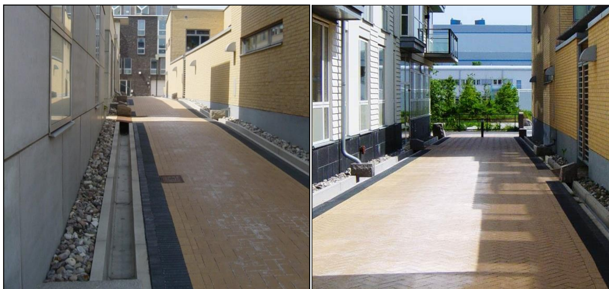
Figur 14. Exempel på rännor och linjeavvattnings längs med byggnader i Malmö (Foto: Norconsult).
