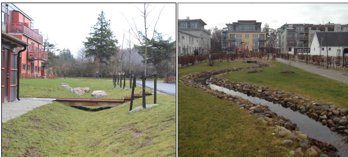
Figur 16. Exempel på svackdike i Gyllins trädgård, Malmö, och ett öppet dike i Lomma (Foto: Norconsult).
