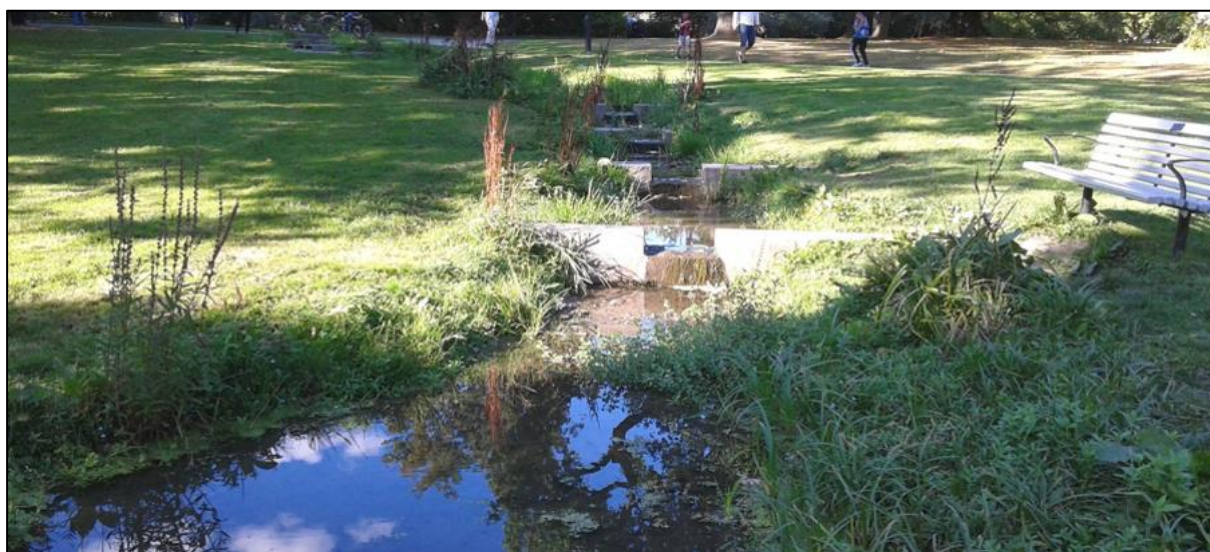
Figur 17. Sektionerade diken med fördröjning och överfall i Slottsskogen, Göteborg (Foton: Norconsult).
